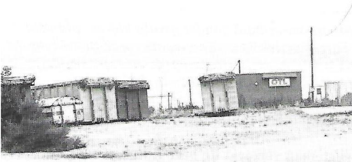
De toegang tot stortplaats O.T.L. aan de Hollebeekstraat (foto uit 1982)
